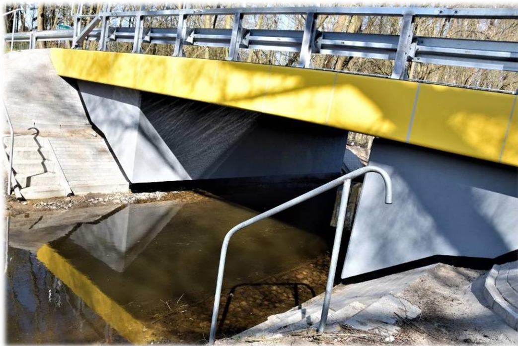
fot. budowa mostu na Kanale Tyczyńskim
